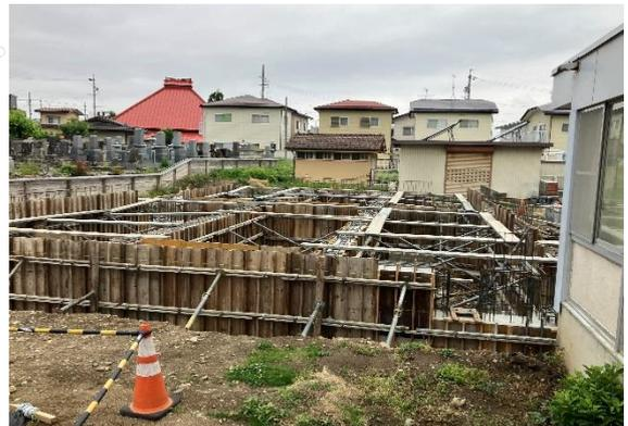
写真は校舎増築の現在(5月19日)の様子です。先週コンクリートが打設され、今週基礎が完成する予定です。計画通りに工事が進められています。
